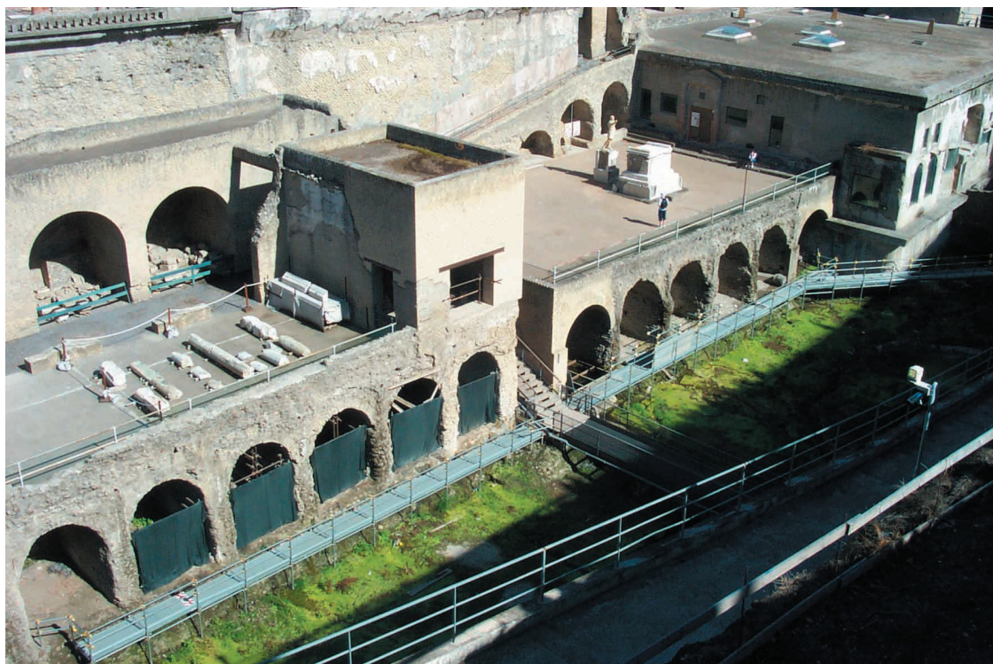
Figura 1.- Scavi di Ercolano, veduta dei Fornici e della rampa di discesa all'antica spiaggia: a destra i 6 Fornici orientali, sovrastati dalla Terrazza di M. Nonio Balbo con l'altare funerario e la statua loricata del patrono di Ercolano; a sinistra i 6 Fornici occidentali sovrastati dall'Area Sacra a Venere (Foto dell'Autore).
